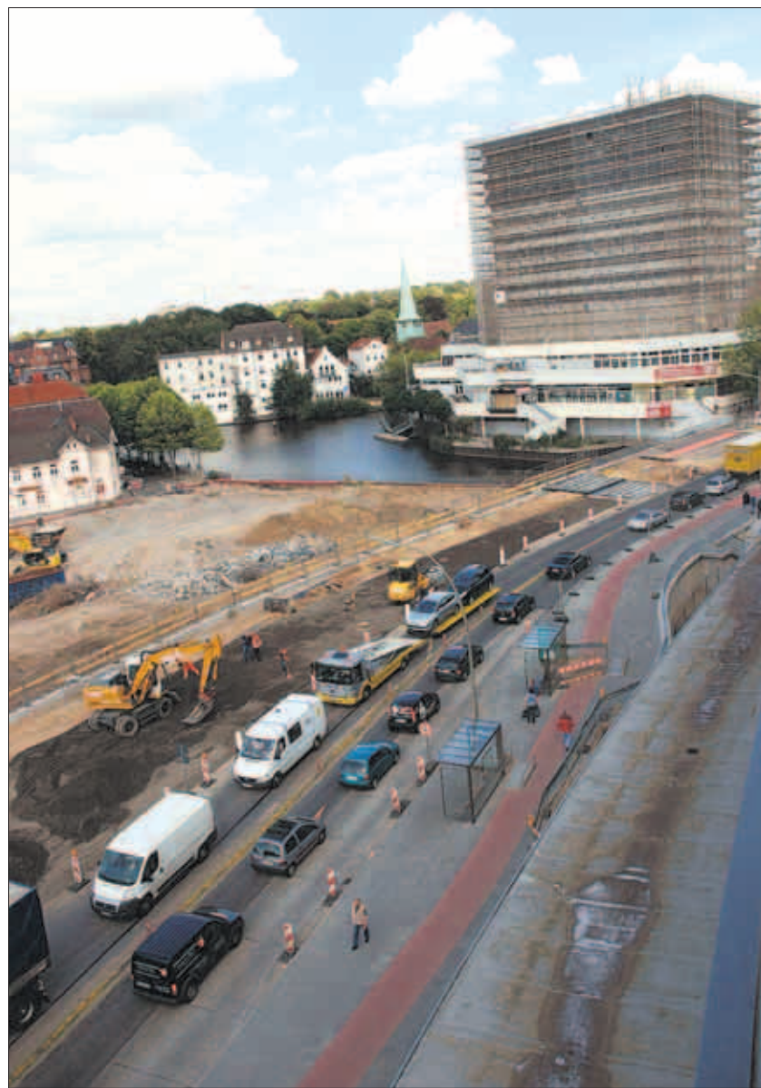
Die Bergedorfer Straße soll von Freitag, 10. Juli, an wieder vierspurig befahrbar sein. Bis dahin werden die Asphaltierungsarbeiten abgeschlossen sein. Schon bis 26. Juni soll ein provisorischer Fußweg auf der Nordseite zwischen Bahnhof/Baustelle und dem CCB fertiggestellt werden. Fotos: Busse
